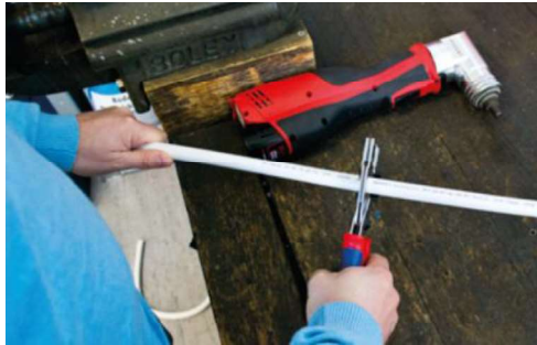
1. Cortar la tubería
